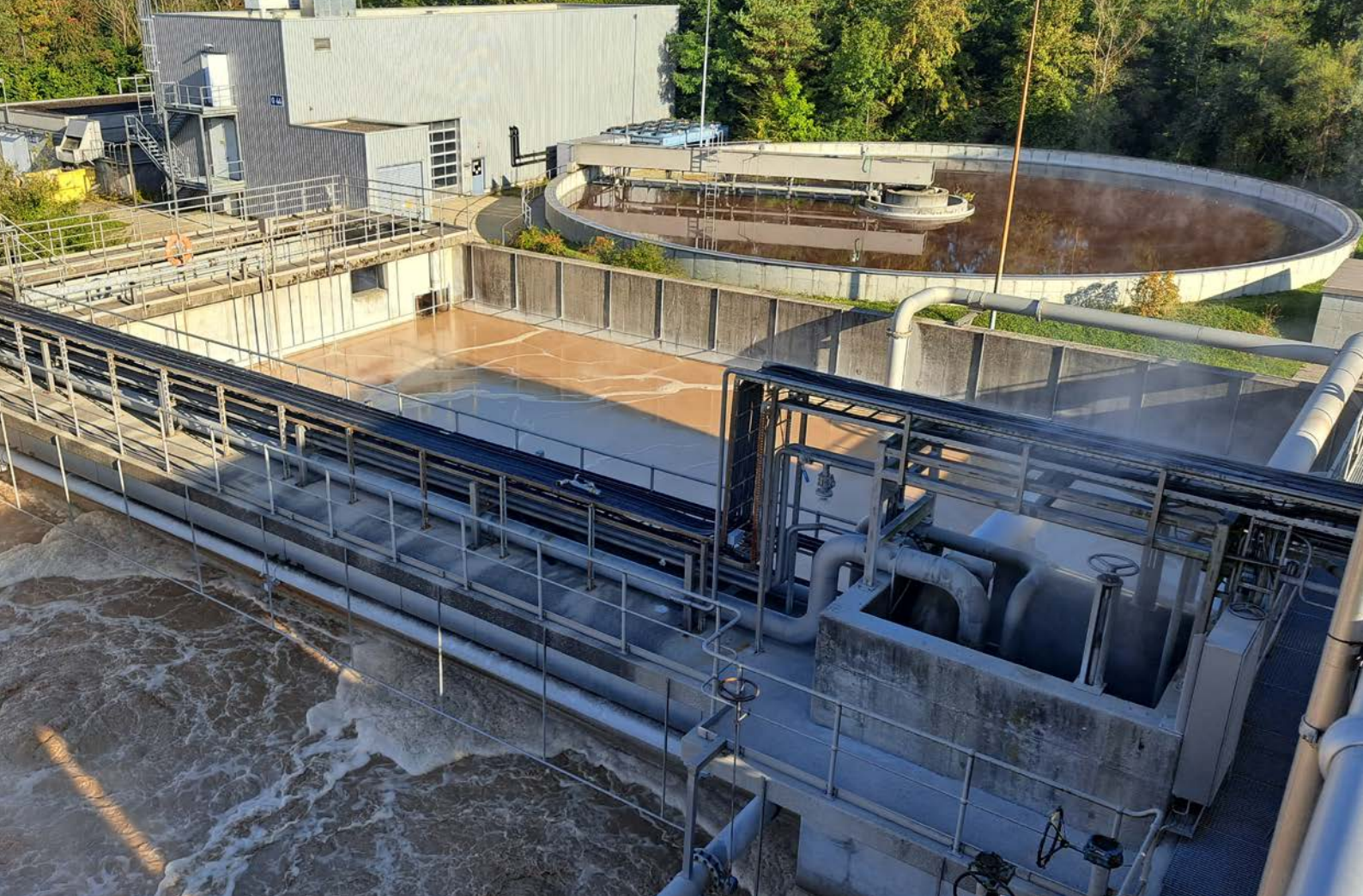
Belebungs- und Nachklärbecken unserer Kläranlage
